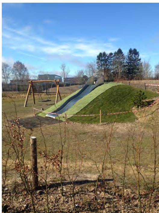
Afspærring rundt om en ny rutsjebane, der endnu ikke er ordentligt fastgjort.
